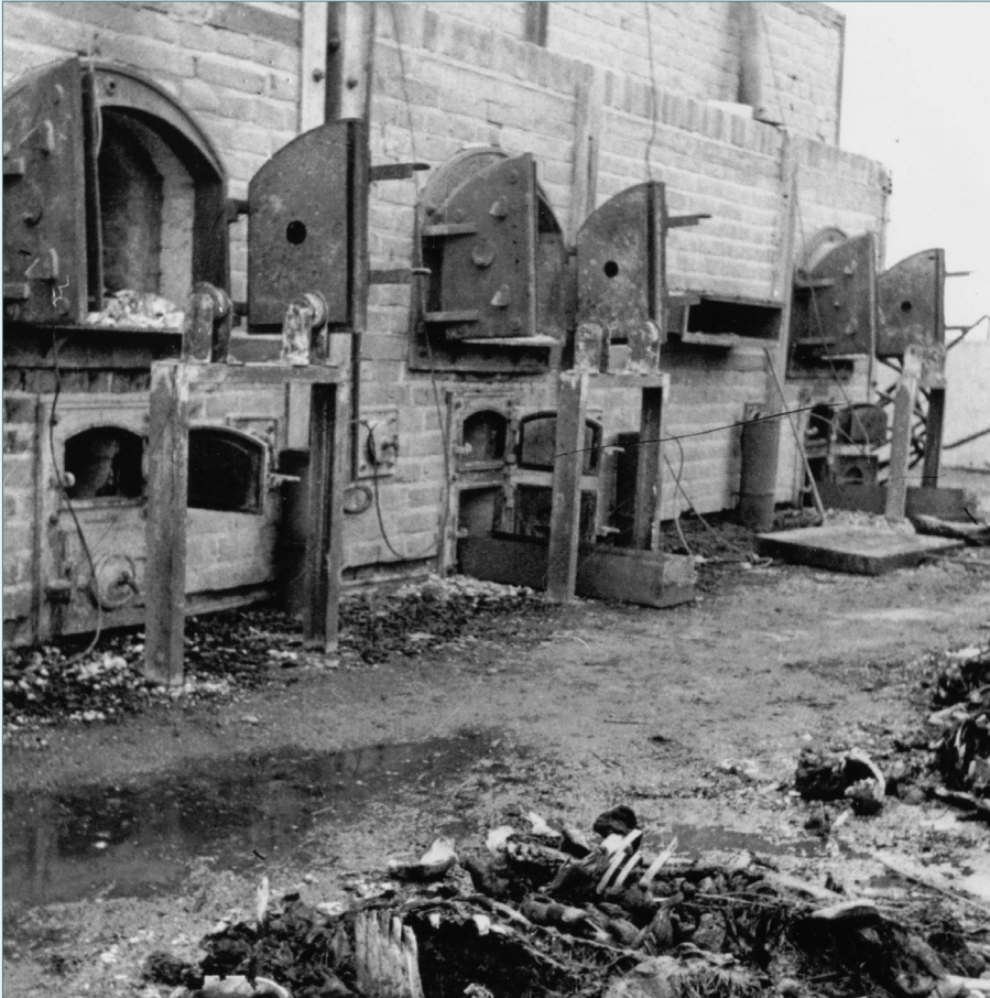
KZ Majdanek (Polen) – Die Verbrennungsöfen mit Skeletten ermordeter Lagerinsassen davor. (Aufgenommen nach der Befreiung durch die Rote Armee am 27. Juli 1944)
